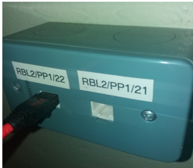
Figura 5.5: Exemplo de identificação de ponto de rede em condutele com dois pontos (X2). Ref. UFFS.
